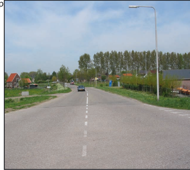
Haarstraat buiten bebouwde kom
